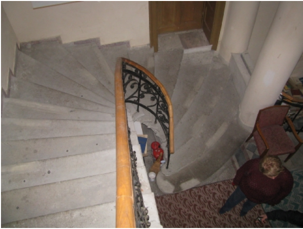
25. Detaliu scara balansata demisol
