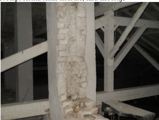
37. Calcan zidărie autodemolat
