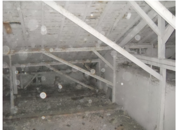
40. Șarpantă și planșeu în zona Aulei
