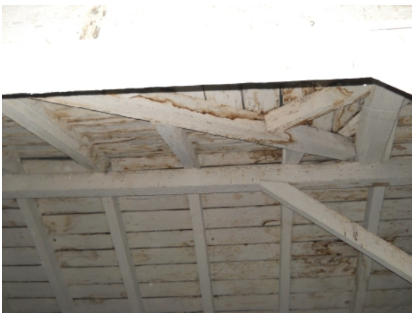
39. Elemente lemn subdiemnsionate, invelitoare neetanșă
