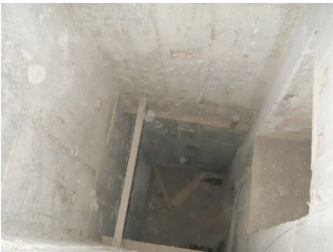
57. Casa liftului mont charge b.a.
