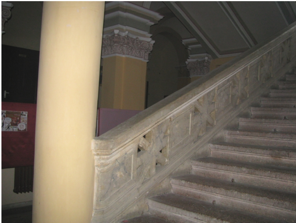
5. Detaliu parapet scara principala de acces la etaj
