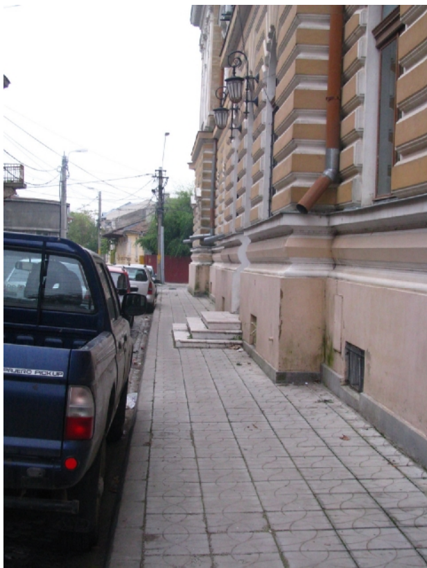
Foto 23 – Detaliu trotuat perimetral cu vegetatie, neetans
