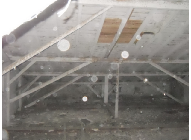
50. Șarpantă subdimensionată
