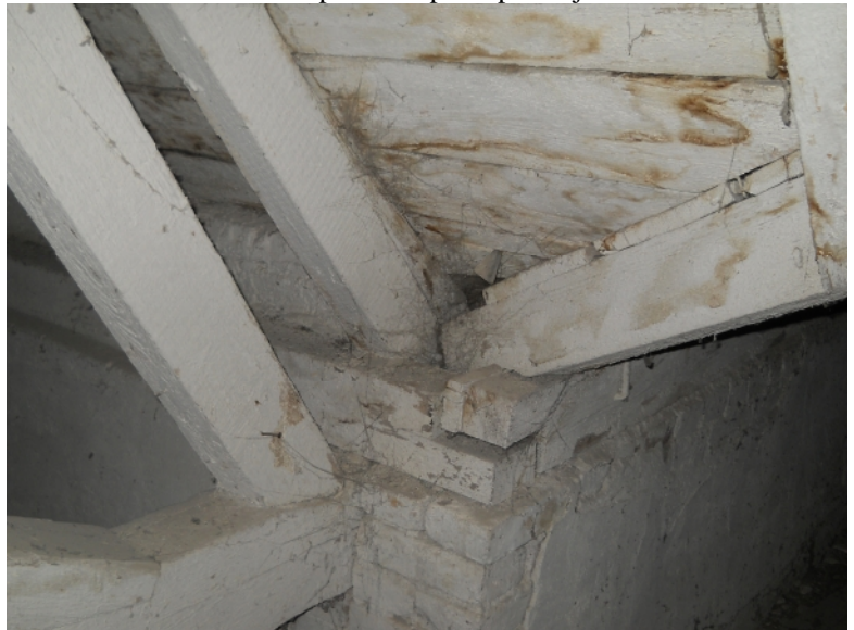
44. Rezemare șarpantă pe atic zona scării principale
