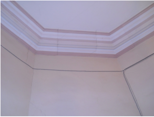
76. Fisuri stucatura planseu octogon parter
