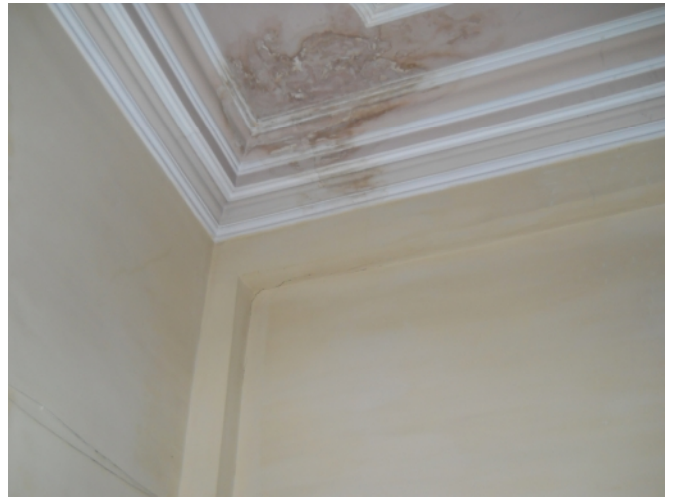
54. Ochi de cadru etaj b.a. umplut cu gips carton
