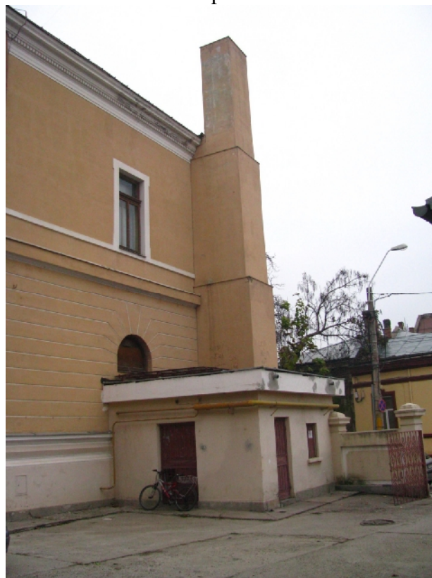
Foto 24 – Detaliu centrala termica+cos de fum
